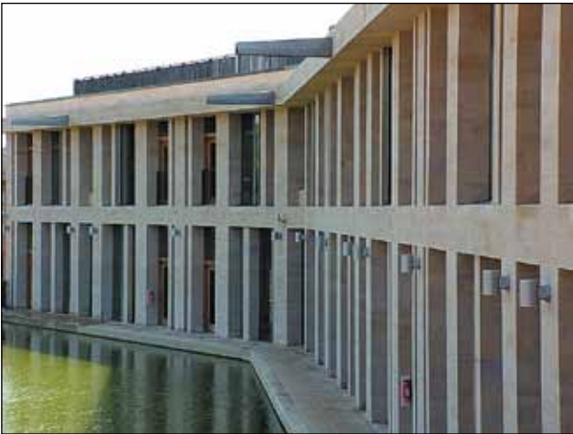
Figur 1. Oundle School's scitec centrum, som för samman vetenskap, konst och teknik, och som har byggts med hjälp av framtidsinriktade hållbar teknik såsom KNX. Källa: Andromeda
